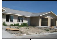
安養中心第二期進行中
