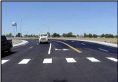
五線道路已完成
